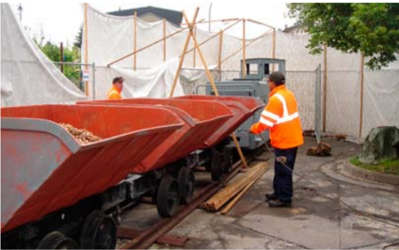
Pendant les travaux
