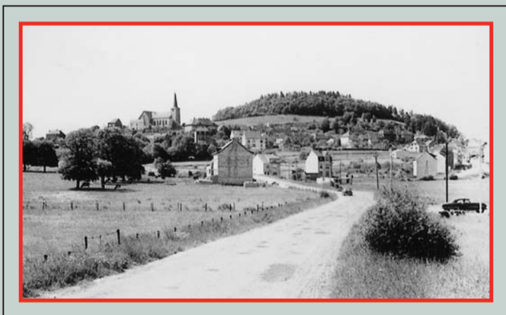
Vue aus der route d'Esch Richtung Zolwer
