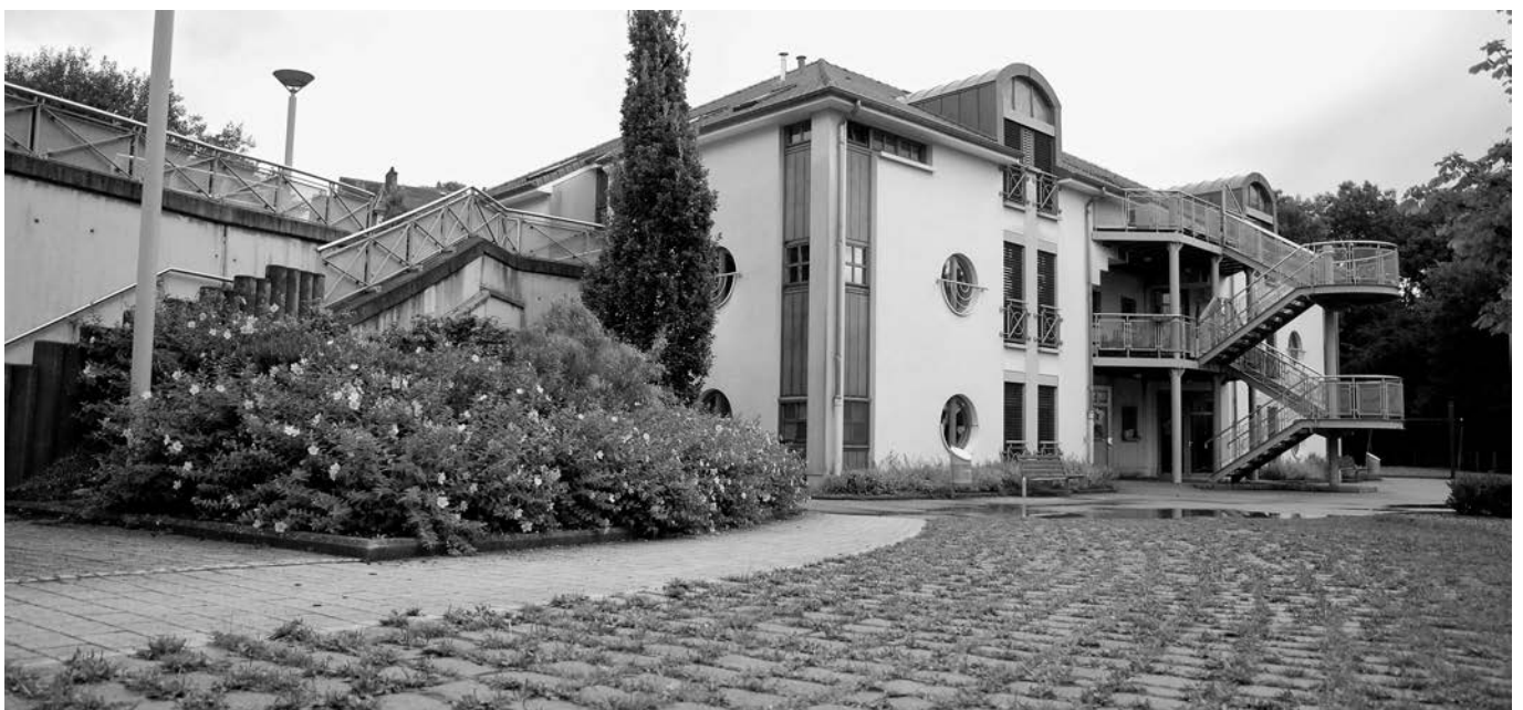
Die „Zolwer Kannerbuerg“ wird Teil der Maison Relais der Gemeinde Sanem.
